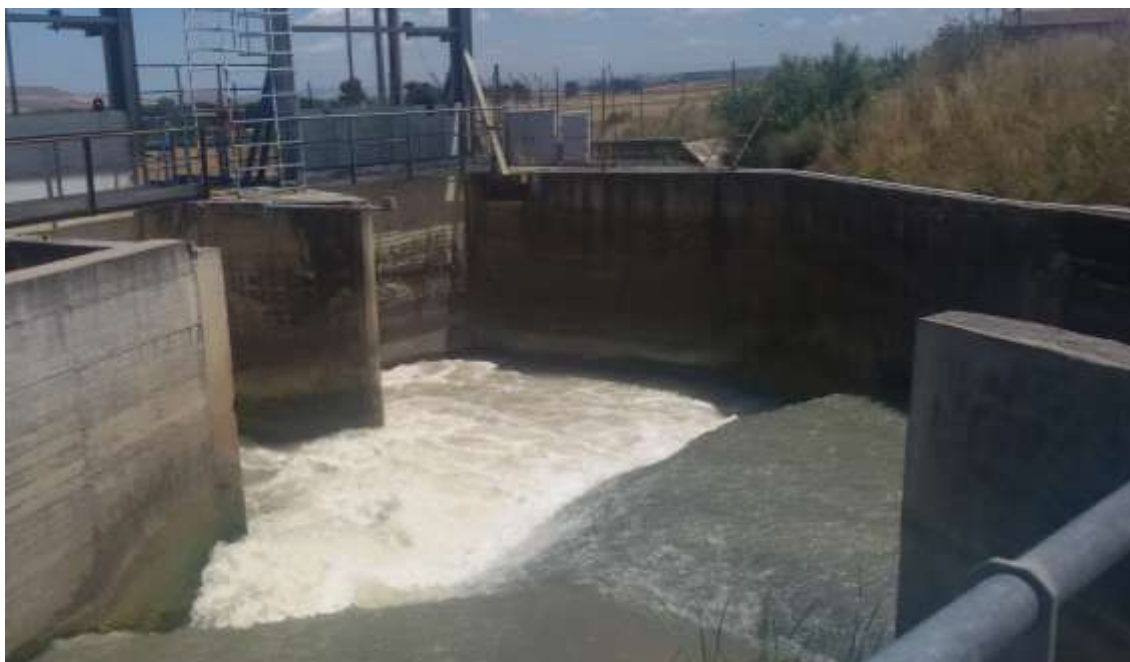
Figura 4 – Foto degli imbocchi alle condotte per i compresori del Locone e di Marana-Capacciotti
